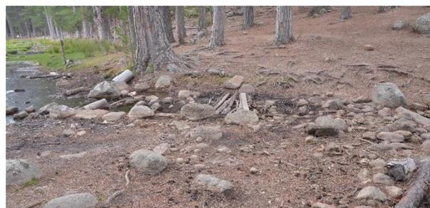
**Figure 19.** Le petit barrage amovible en été (17 août 2019). © G. Paradis. Une planche disposée verticalement et qu'on peut enlever permet de moduler le niveau de l'eau en été. Ainsi, en juillet 2020, de l'eau s'écoulait par l'exutoire, la planche ayant été enlevée par les agents du PNRC.
