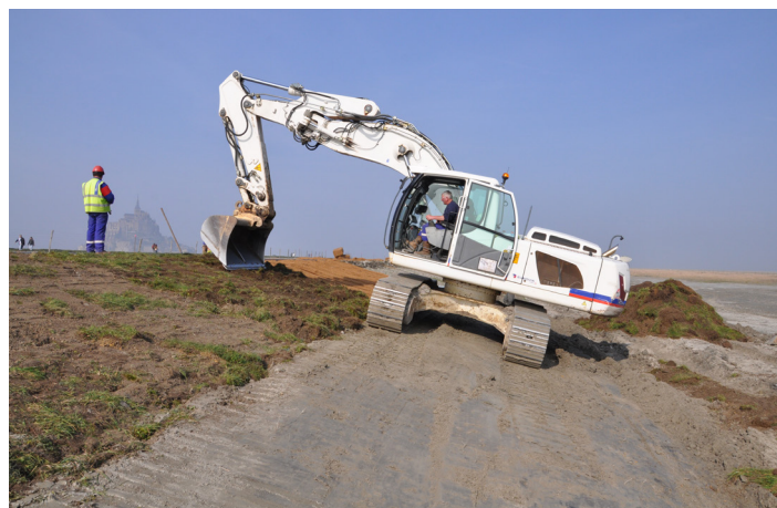
Figure 5. Transfert de la terre de la digue historique sur la nouvelle digue d'accès au Mont-Saint-Michel en mars 2014.
